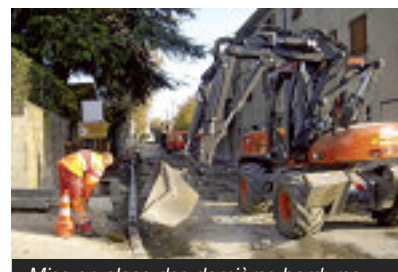
Mise en place des dernières bordures
